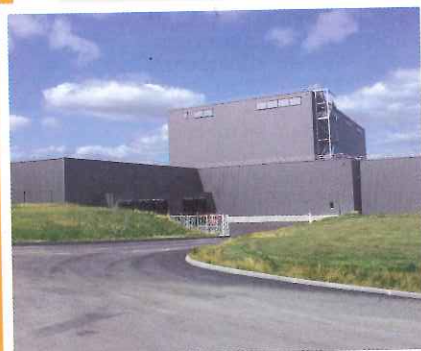
Kermené (Saint-Onen- 35) - Extension de la plateforme frigorifique - 2016
