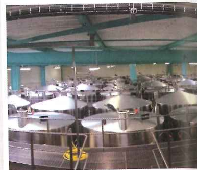
Champagne Laurent Perrier (Tours-sur-Marne-51) - Extension du site (cuveries, atelier de remuage) - 2016
