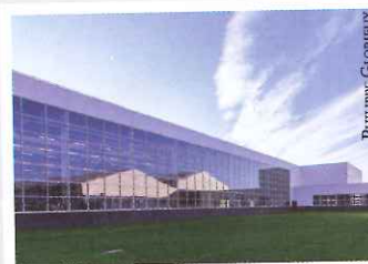
Candia (Lons-64) - Extension du site de conditionnement de lait UHT-2016
